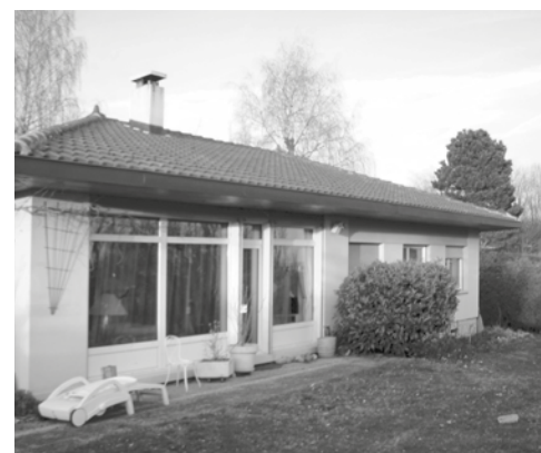
Vues nord et sud avant travaux
