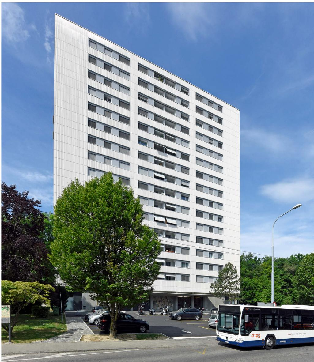
ventilée en céramique émaillée, dotée d'une isolation en laine minérale. Le remplacement des fenêtres à triple vitrage offre une isolation thermique et phonique de grande qualité.
